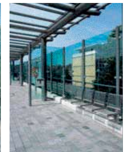
Na de reiniging: verharding als nieuw.
