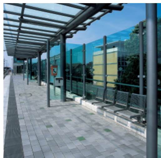
Na de reiniging: verharding als nieuw.
