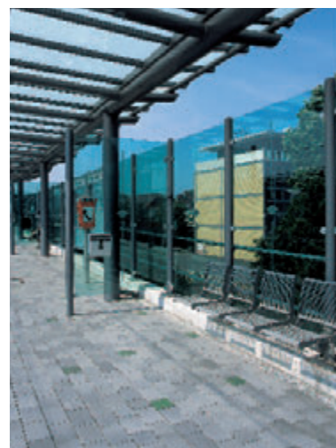
Na de reiniging: verharding als nieuw.
